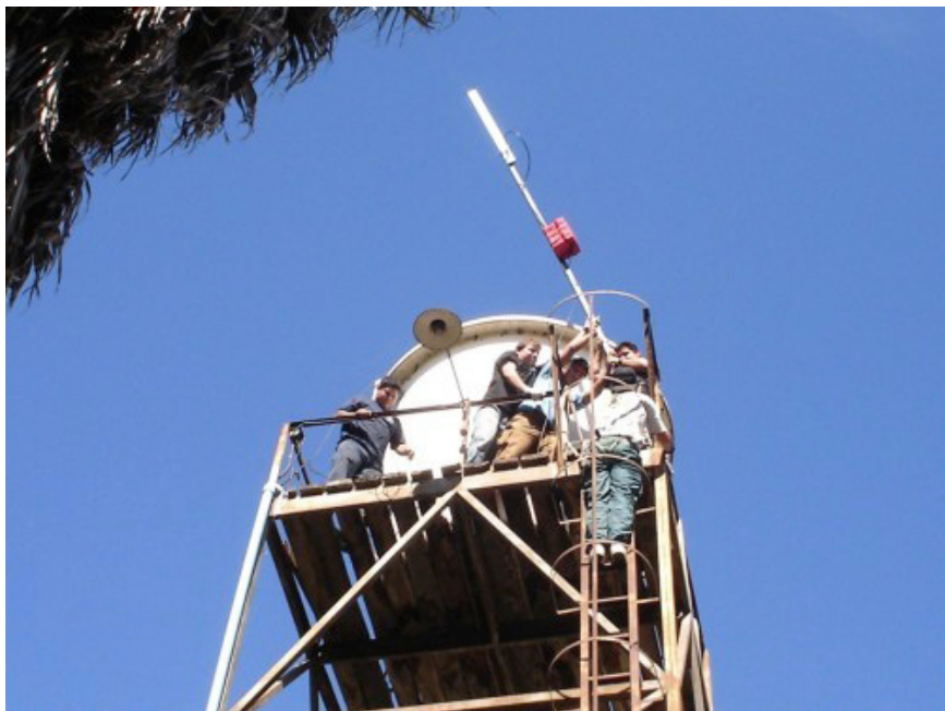
Figura 11.24: Implantação de um nó em uma caixa d'água em Batuco, na região metropolitana, que provê o link para o telecentro Cabrati.
