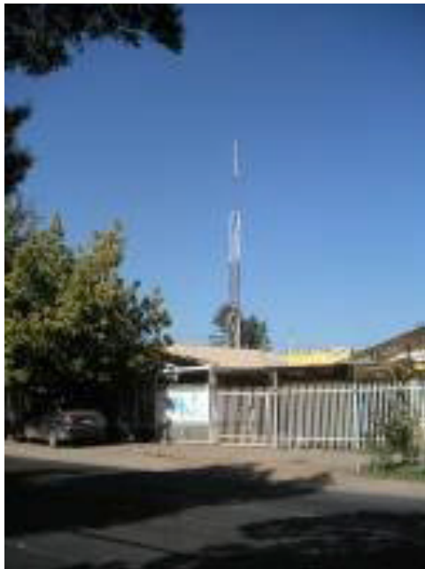
Figura 11.21: Nó na região sul de Santiago, formado por uma torre de 15 m, uma antena Trevos Marshall 16+16 e 30 clientes. Este nó está conectado a outro no centro da cidade, a mais de 12 km de distância.
