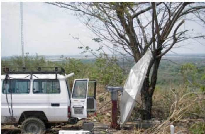
Figura 11.34: Instalação da antena em El Baúl. A inclinação real é de 1^\circ para cima, já que o offset da antena é de 22,5^\circ .
